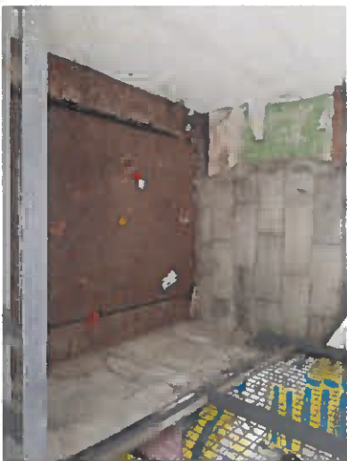
3 - Réservation pour emplacement d'ascenseur
